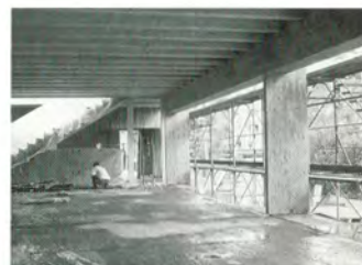
Entlang der Hauptfassade, in den Unterrichtsräumen, sind jeweils vier Achsmasse mit einem massiven Unterzug zusammengefasst. Verglasungen über die ganze Raumlänge lassen eine intensiven Bezug zum Park entstehen, der bei den Schiebefenstern aber durch die Radiatoren (Absturzicherung) relativiert wird.
