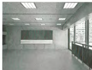
Entlang der Hauptfassade, in den Unterrichtsräumen, sind jeweils vier Achsmasse mit einem massiven Unterzug zusammengefasst. Verglasungen über die ganze Raumlänge lassen eine intensiven Bezug zum Park entstehen, der bei den Schiebefenstern aber durch die Radiatoren (Absturzicherung) relativiert wird.
