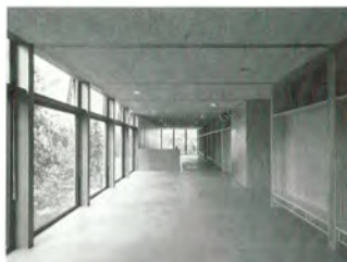
Der Gebäuderaster ist im Innern präsent, wird aber durch einen Farbanstrich visuell homogenisiert.
